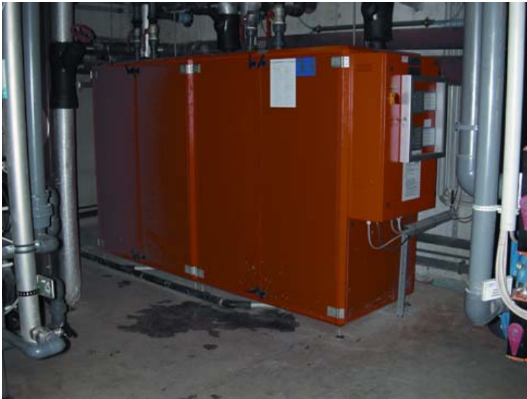
Menerga Wärmerückgewinnung aus Abwasser mit automatischer Wärmetauscherreinigung
