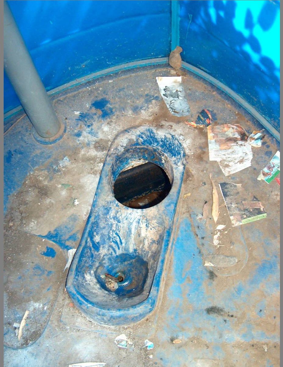
Urinseparationstoilette (Kotido, Uganda)
